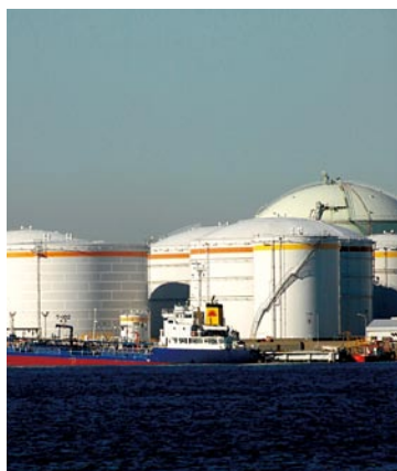
LNG プラント
