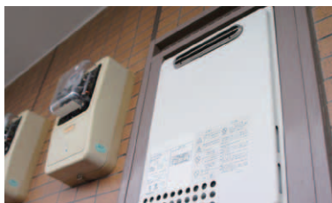
ガス燃焼装置の微小電流測定に DCμAレンジ DT4253 のみ
